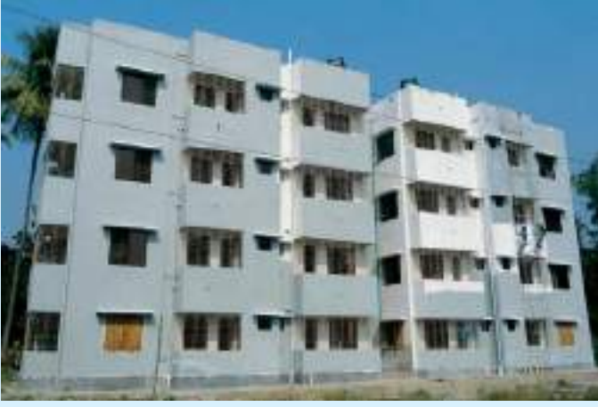
শিক্ষক ও কর্মকর্তাগণের নবনির্মিত আবাসিক ভবন।
